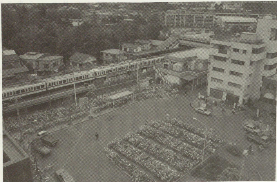
▶狛江駅の現況。手前は昭和四十四年に完成した南口広場。上部は整備計画を進めている北口部分
